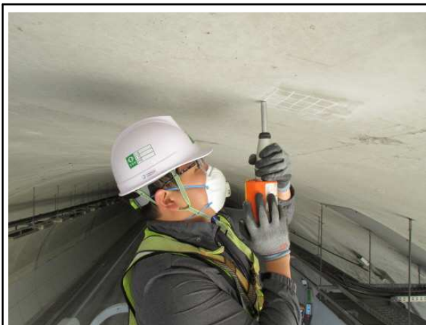
내 용 반발경도법을 이용한 압축강도 시험
