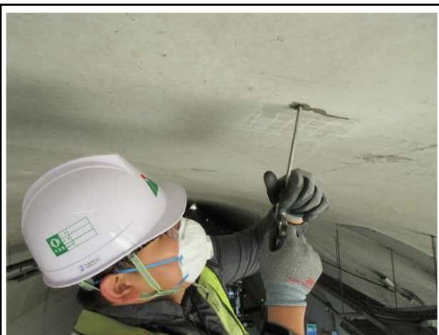
내 용 페놀프탈레인 용액을 이용한 탄산화 측정
