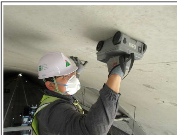
내 용 철근탐사시험(피복두께 확인)
